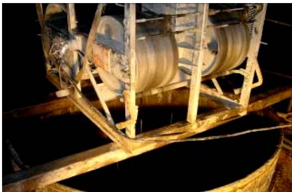
照片5 孔壁垂直度檢測
