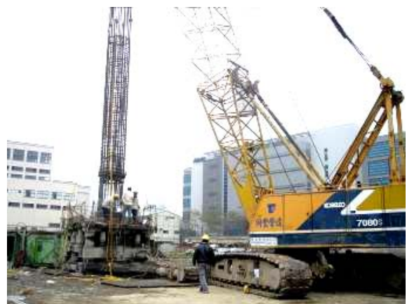
照片6 鋼筋籠吊放
