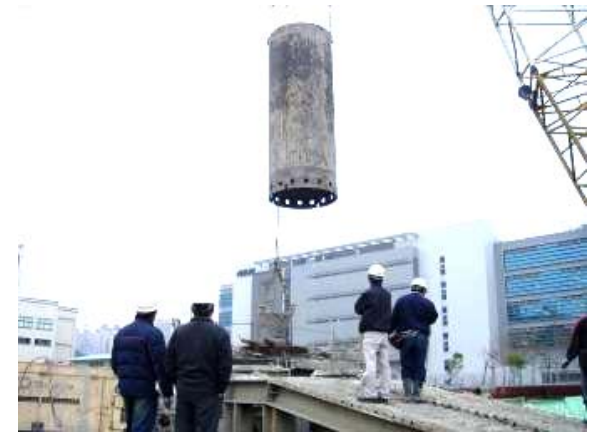
照片16 混凝土澆灌過程中分段拔出套管
