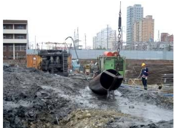
照片4 取土筒清除孔底沉泥
