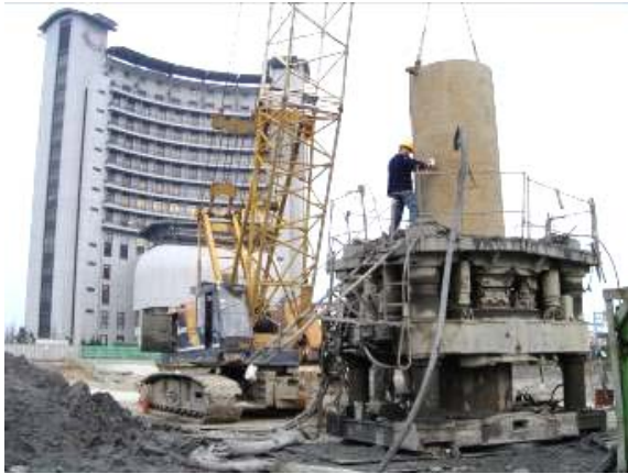
照片1 套管裝設(全迴式套管機)
