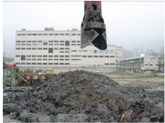
照片2 鑽孔掘削抓斗取土
