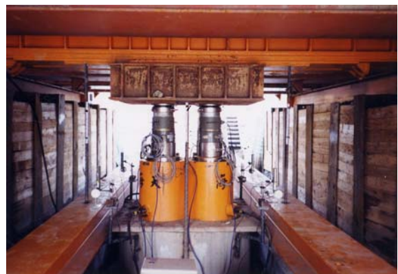
照片12 樁頭監測儀器安裝
