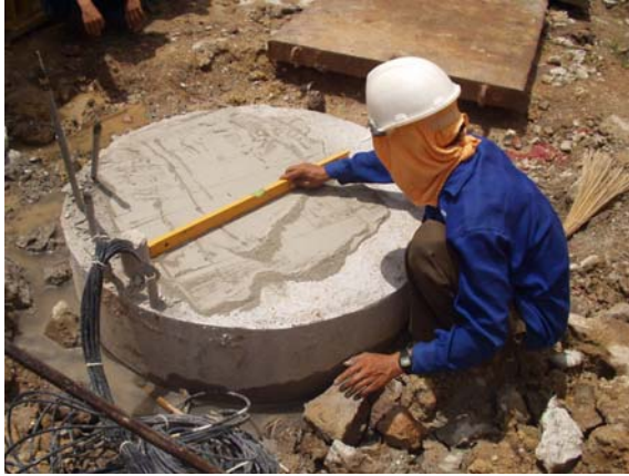
照片1 樁頂抹平(水泥粉或細砂)
