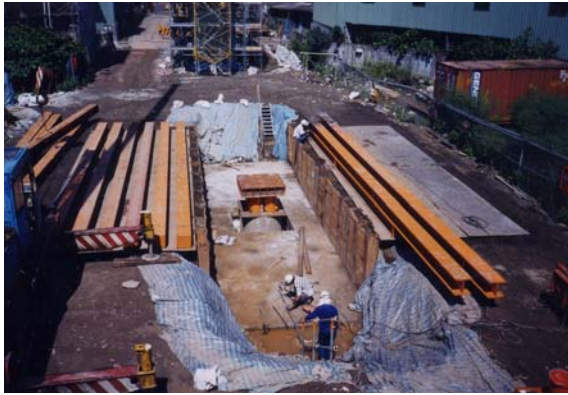
照片1 假設工程施工
