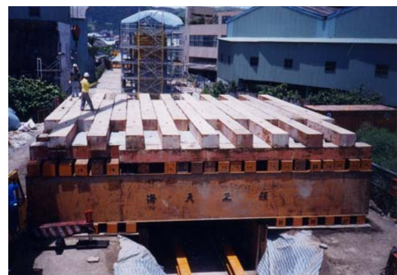
照片6 混凝土呆重塊吊裝一
