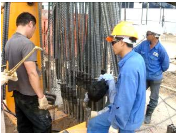
照片5 錨錠鋼筋壓接或焊接
