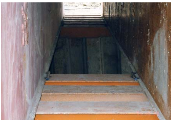
照片11 鋼樑臨時固定(焊接)
