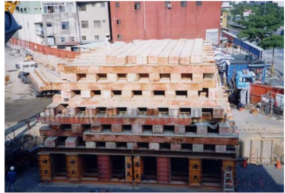
照片8 混凝土呆重塊吊裝三
