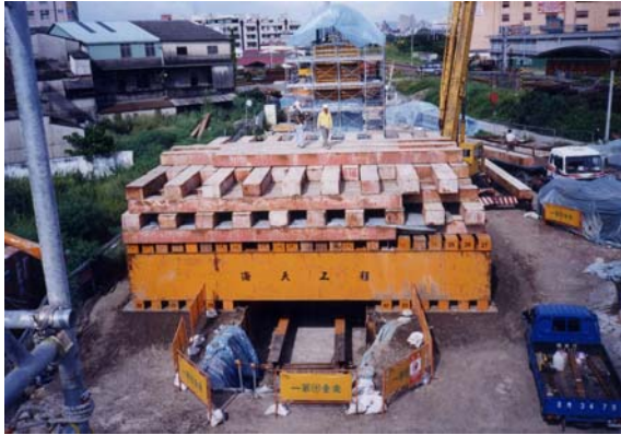
照片7 混凝土呆重塊吊裝二
