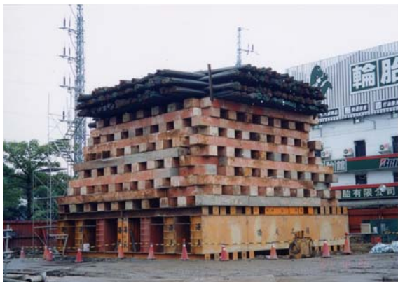
照片9 呆重平台安裝完成(頂端堆疊鋼筋供呆重)
