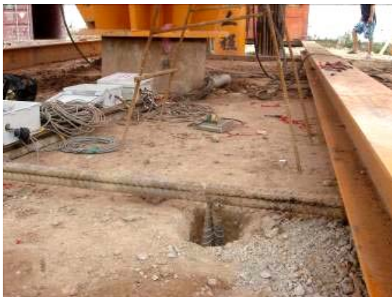
照片3 參考梁支撐與架設
