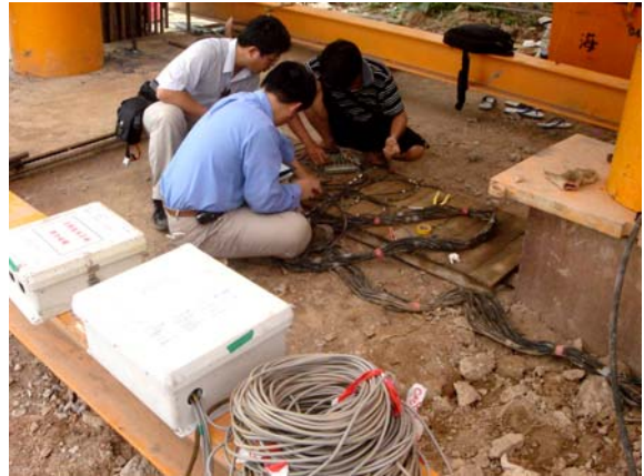
照片8 自動監測系統接線
