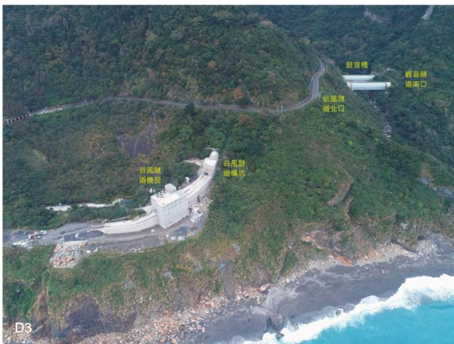
D3 觀音與谷風隧道以長僅 60 公尺鼓音橋銜接，二座隧道合併鼓音橋作為整體防災考量，則總長為 12.6 公里，為省道公路最長隧道。照片為谷風隧道橫坑及機房，遠方為鼓音橋，銜接觀音隧道南口與谷風隧道北口
