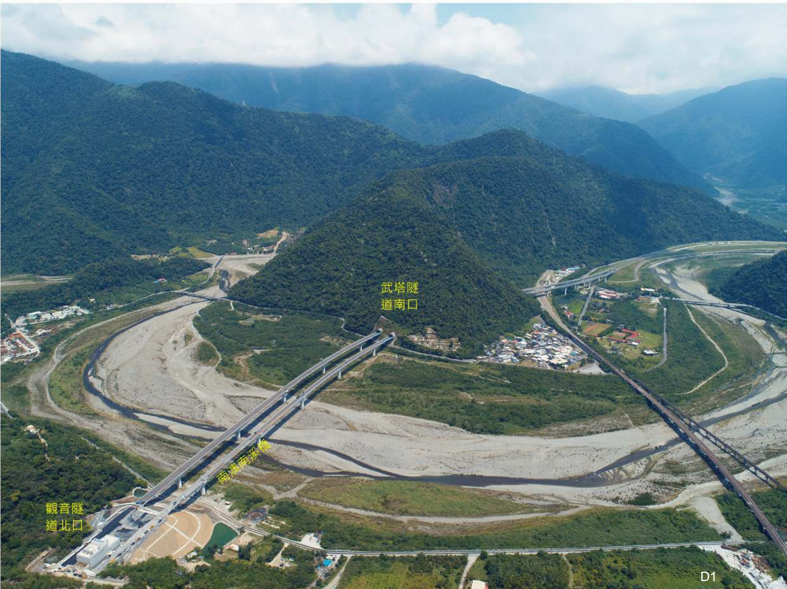
D1 照片為武塔隧道、南澳南溪橋及觀音隧道北口，遠方為本工程開挖土方回填構築之南澳路堤段
