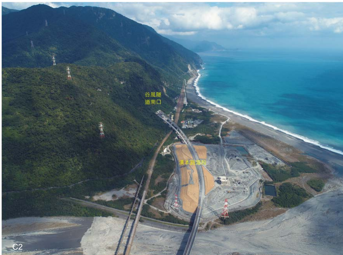
C2 本工程開挖土方回填之漢本路堤段，遠方為谷風隧道南口及太平洋
