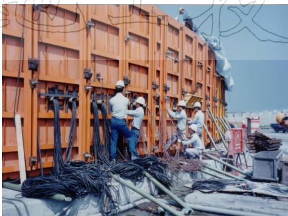
高雄 LNG 油槽安全監測儀器裝設(1989)
