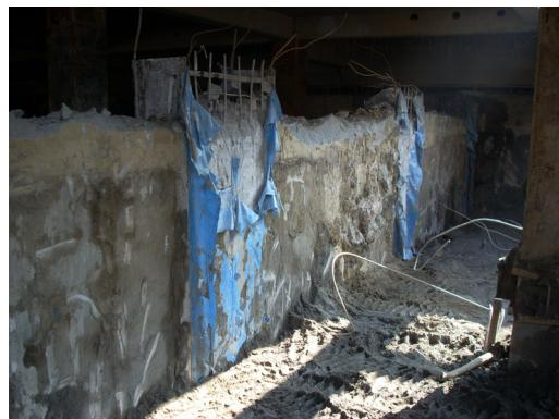
照片二 開挖面地中壁保留未敲除狀況
