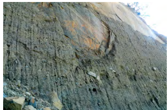
圖七 大削壁上的舊崩積層極薄，局部僅數公分厚或直接露出削壁上的頁岩
