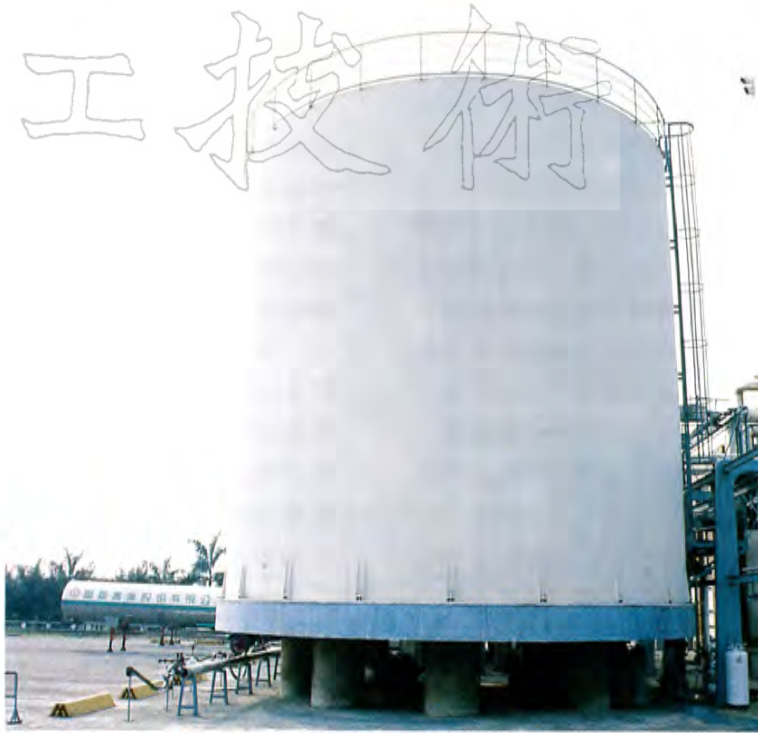
圖三 基礎型式之液化氮儲槽基礎
