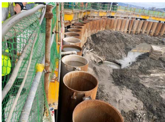
圖十四 主橋塔鋼管樁圍堰
