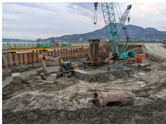
圖十六 主橋塔基礎施作全套管場鑄樁情形
