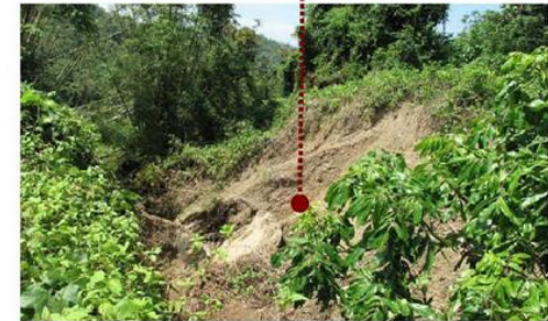
圖十六 莫拉克颱風後寶隆場址坡趾處局部崩滑情形
