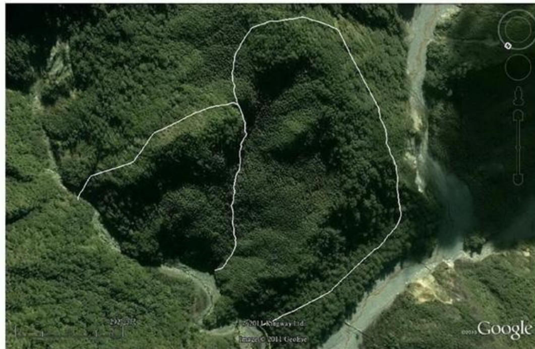
影像四 逆向坡滑動及堰塞湖
