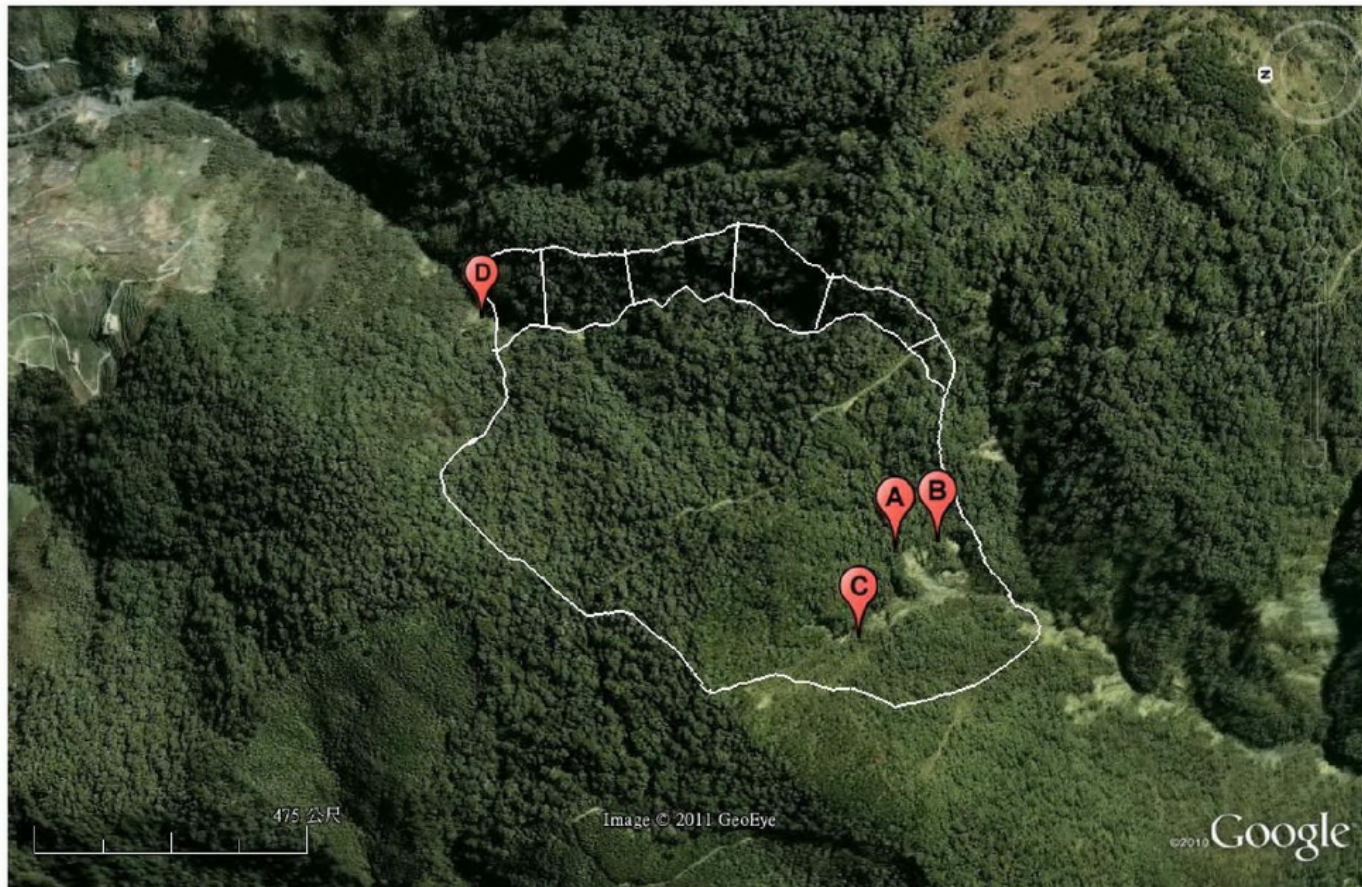
影像三 北港溪上游的逆向坡深層滑動
