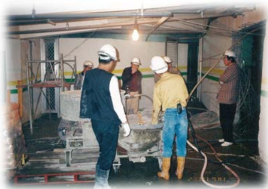
照片八 921 斷層帶建築物震損，胡博士協助進行室內抬升灌漿補強
